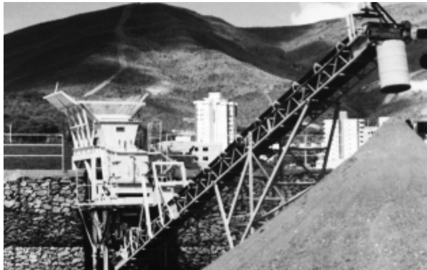
Usina de Reciclagem de entulho de B.H. – Esteira
